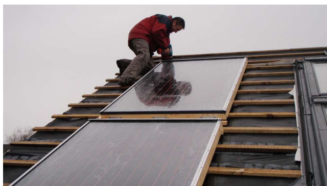
kollektor készítés. szerelés
